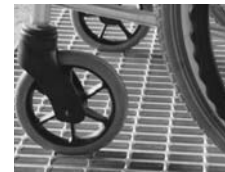
車輪がはまり込まず滑りにくいグレーチング
