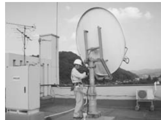
衛星空中線設置
