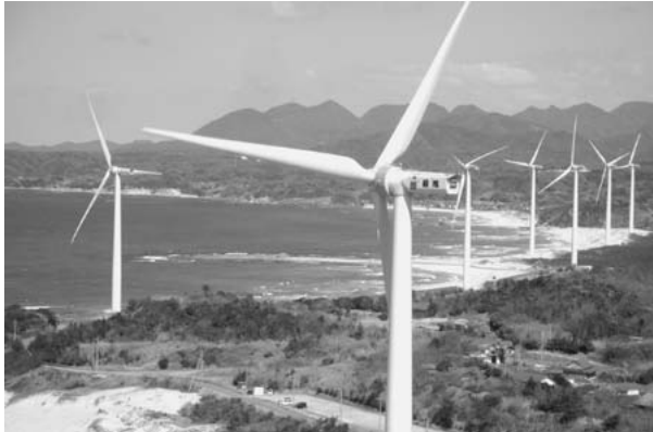
江津東ウィンドファーム風力発電所
