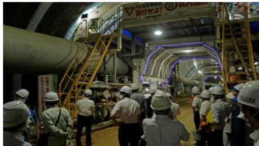
【東広島・安芸バイパス建設現場見学会】
