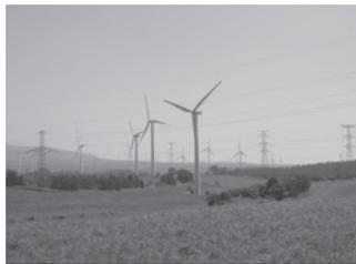
「むつ小川原ウインドファーム」は風車21基、総発電出力31,500kWと国内最大級の規模であり、年間約5,800万kWhを発電している。(一般家庭約16,600世帯の年間消費電力量相当)
