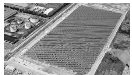
中国電力福山太陽光発電所 (長州産業製太陽電池モジュール採用)
