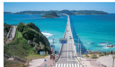
角島大橋 (下関市)
