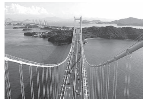
瀬戸大橋 写真提供:本州四国連絡高速道路㈱
