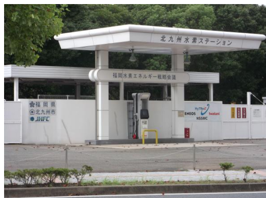
写真. 水素ステーション
