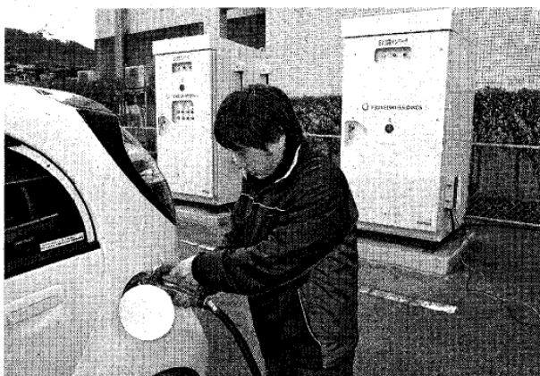
電気自動車を使い、施設へ電力を給電する装置＝広島県福山市
