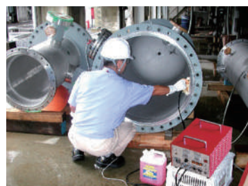
電解処理の状況
