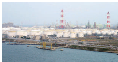
施工高日本一を誇る石油化学 プラント塗装メンテナンス
