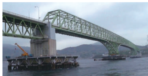
橋梁補修（防災）工事を施した大島大橋
