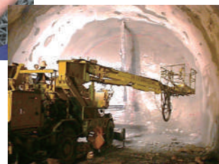
「バルチップ」のトンネルでの施工
