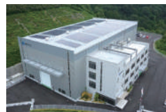
電機システム開発センター
