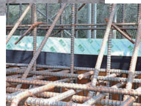
「スパンシール」の施工箇所
