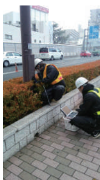
超音波センサを当てるだけの測定模様
