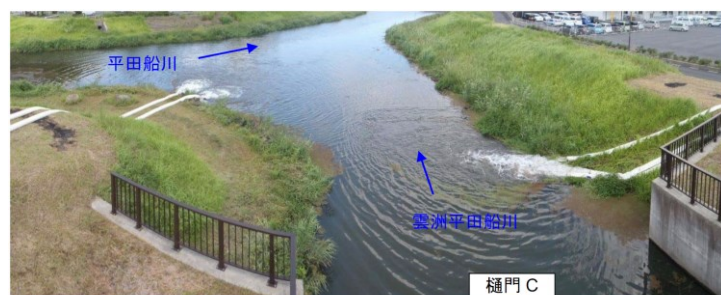
平田船川へのポンプ車からの排水状況
