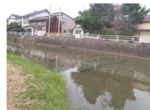
炭素繊維設置状況 （平成 26 年度）
