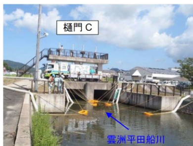
ポンプ車稼働状況
